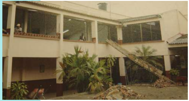
▶ Remodelación en la sede ubicada en Ciudadela Colpuerto.
