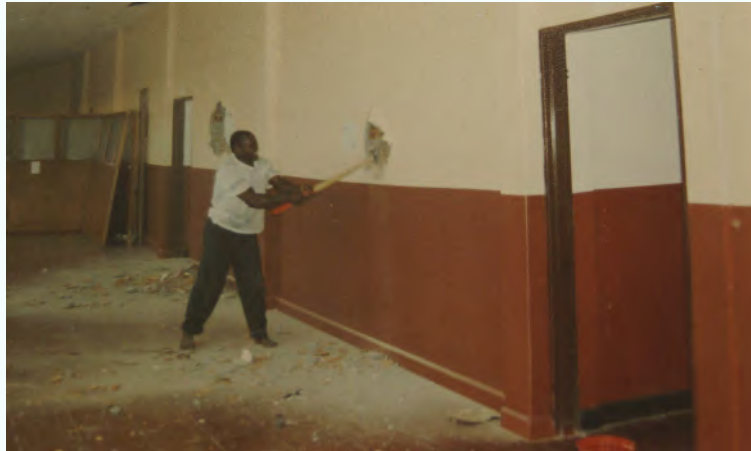
Primer golpe para construir los talleres de arquitectura.
